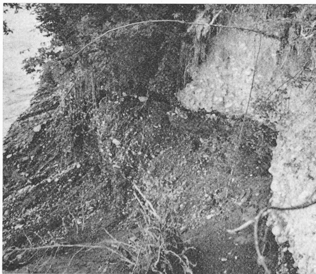
Fig. 14. — Falaise en alluvion ancienne (GM, GP, GW indurée par zones) érodée par le batillage de la retenue de Verbois. Photo prise pendant la vidange, la zone foncée est normalement sous l'eau.
