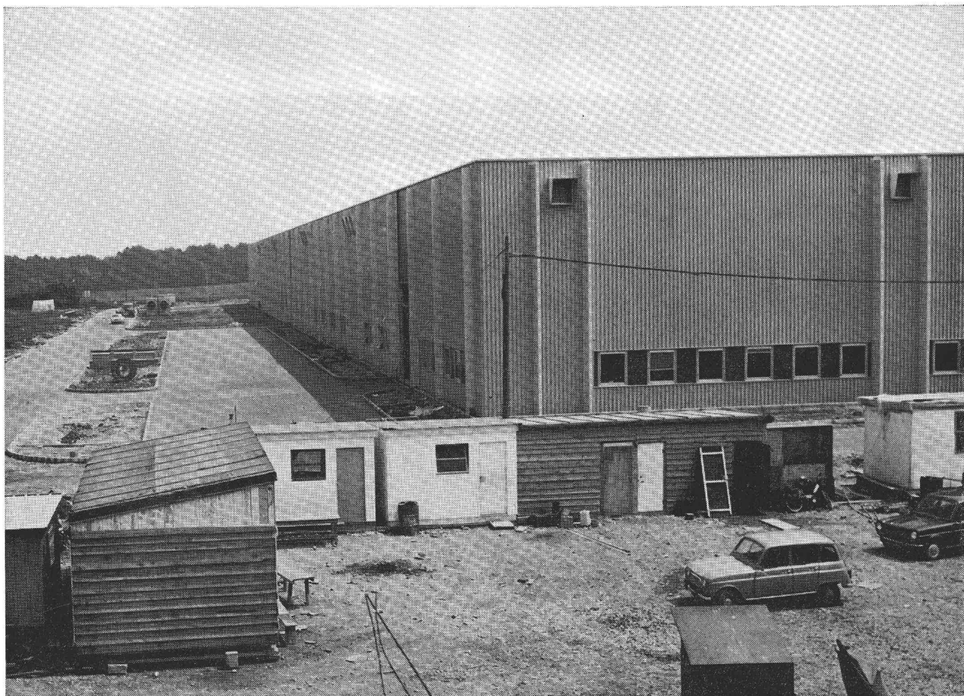
Revêtement de façade et supports toiture en acier nervuré ACIÉROÏD d'une halle de montage au CERN (Centre européen de recherche nucléaire) près de Genève — Surface 20 000 m 2 .
