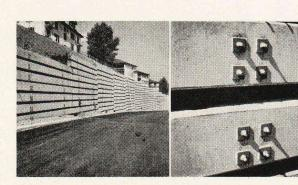
Eléments en béton fixés dans des pieux au moyel de boulons d'ancrage AREFIX.
