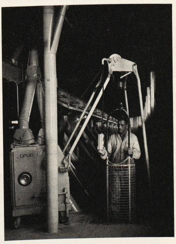
Nos treuils de silo sont conformes et approuvés par la CNA. Ils sont équipés avec un câble de levage principal et un câble de sécurité.
