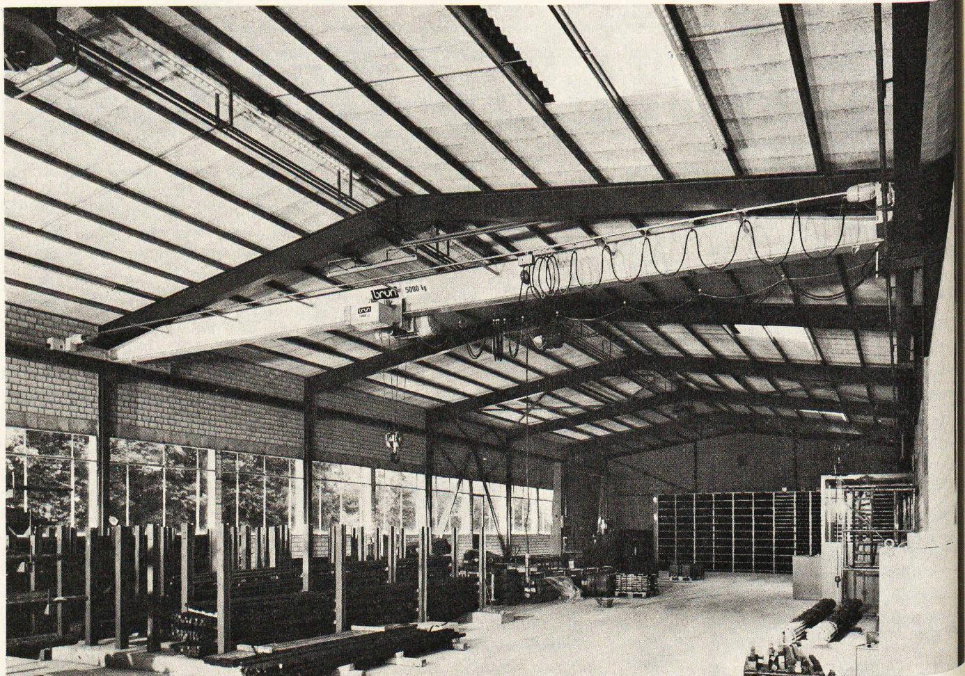
Les pont-roulants monopoutres standard BRUN sont entièrement exécutés avec des éléments normalisés de notre propre fabrication.
