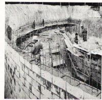
Eléments Coffra pour construire des murs en béton sans coffrage
