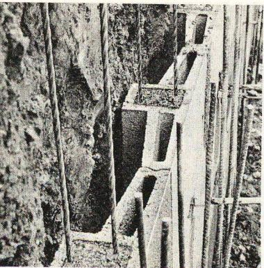
Notre solution permet de réaliser en une seule opération un coffrage rapide et un drainage efficace. La sécurité supplémentaire et la rationalisation qui en résultent sont particulièrement favorables pour les constructions en limite de propriété et là où il y a des risques d'éboulements.
