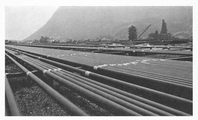
Fig. 4. — Le chantier d'assemblage des tubes au Bouveret.
