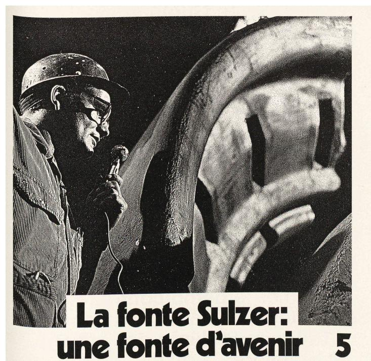
Il ne s'agit pas de vous présenter ici une nouvelle étoile de la chanson, mais notre contre maître Antoine Untersander. Il ne s'adresse par conséquent pas à un amplificateur de 80 watts mais à un pont roulant de 80 tonnes, par lequel il met en place au millimètre près, dans l'atelier de moulage de grosses pièces, le noyau pour la bâche d'une turbine à vapeur.
