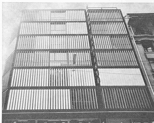
Fig. 4 et 5. — Deux récents exemples de la mode du brise-soleil genevoise. Les façades photographiées sont orientées vers le nord . L'inopportunité des protections solaires est évidente. (Photos KLEMM.)
