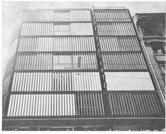
Fig. 4 et 5. — Deux récents exemples de la mode du brise-soleil genevoise. Les façades photographiées sont orientées vers le *nord*. L'inopportunité des protections solaires est évidente. (Photos KLEMM.)
