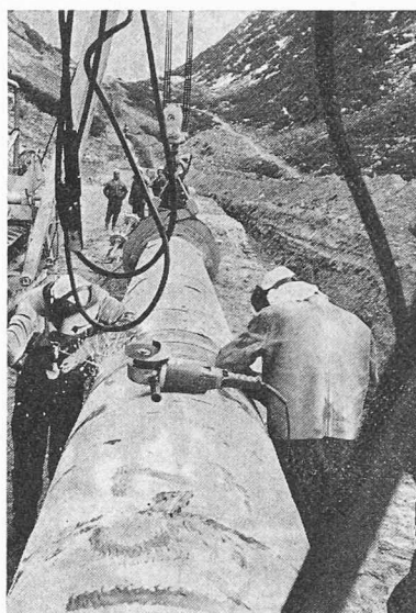
Soudeurs au travail sur un chantier de pose du gazoduc de transit Hollande-Italie, dans le val d'Aegina (VS).
