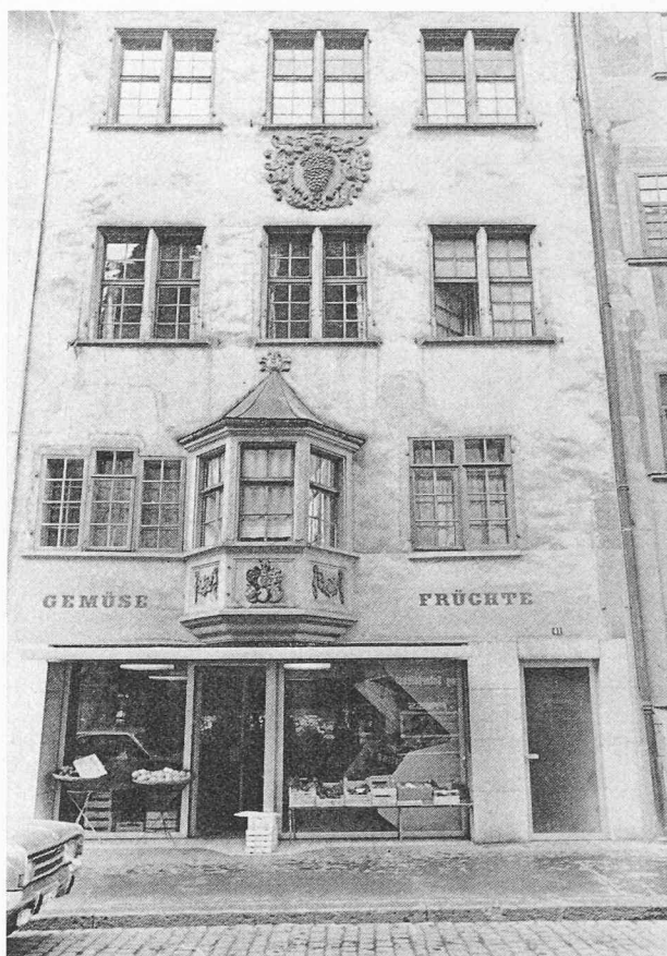
Fig. 42. — Schaffhouse . On peut être encore heureux que la construction de la devanture n'ait pas eu besoin de mordre davantage sur l'encorbellement de l'oriel.
