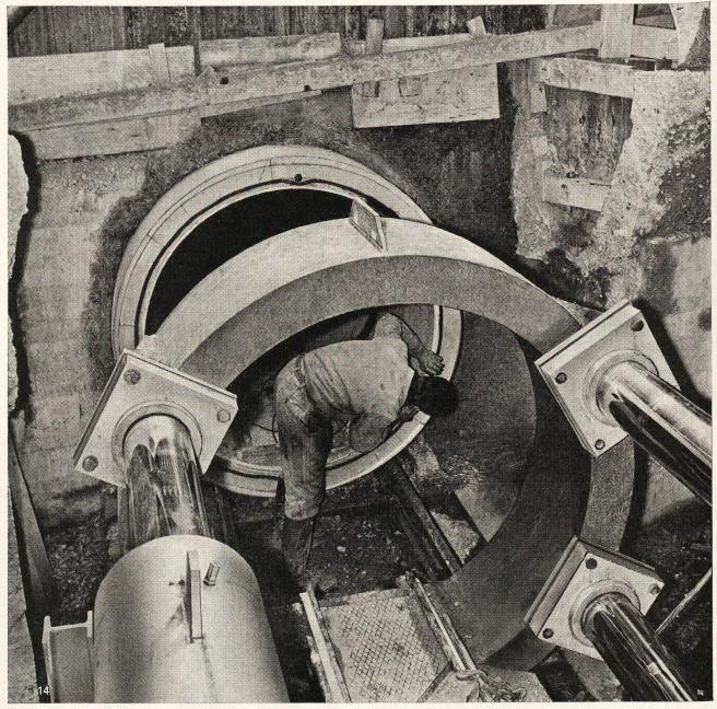
Lorsque la pose de conduites en tranchées ouvertes se heurte à des difficultés, l'ingénieur a recours au procédé par pousse-tube: de puissants vérins enfoncent les tuyaux dans le sol, aussi bien sous les routes et les voies de chemin de fer que sous les immeubles.
