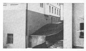
Fig. 8. — Même maçonnerie que figure 2, après assainissement par électro-osmose. Prise de vue douze ans après l'exécution de l'assèchement.
