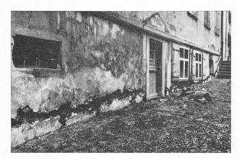
Fig. 2. — Maçonnerie fortement pénétrée d'humidité. Prise de vue durant le montage de l'installation électro-osmotique d'assèchement. Voir aussi figure 8.
