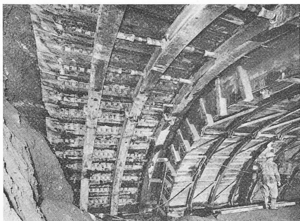
Fig. 8. — Avancement de la calotte en moraine. Bétonnage du revêtement primaire.
