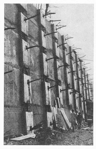
Fig. 8. — Murs à contreforts ancrés. Vue générale.
