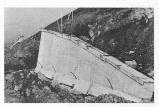
Fig. 6. — Murs poids à semelle ancrée. Vue partielle.
