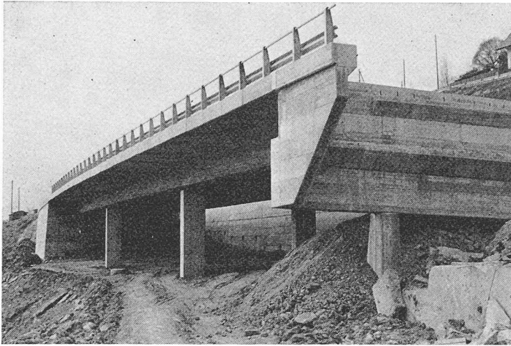
Fig. 3. — Vue de l'ouvrage terminé.
