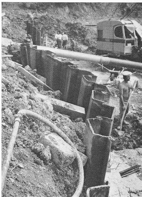
Fig. 3. — Basculement des palplanches.
