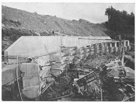
Fig. 11. — Exécution du troisième niveau des ancrages.
