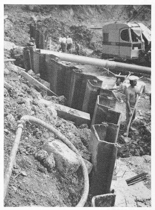
Fig. 3. — Basculement des palplanches.
