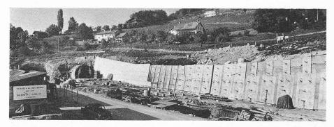
Fig. 5. — Mur de Chauderon. Vue d'ensemble, piliers et placage.
