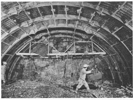
Fig. 2. — Tunnel de Chauderon, tôles Bernold au front d'attaque.
