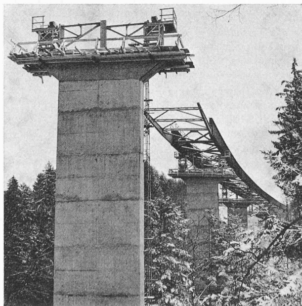
Fig. 4. — Lancement de l'ossature métallique du pont aval.
