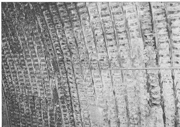
Fig. 6. — Tôles Bernold et mortier forment un étroit alliage.
