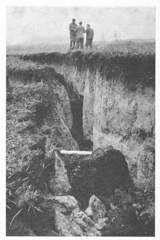
Fig. 8. — Fissure dans la craie lacustre, apparue à peu de distance de l'Areuse.
