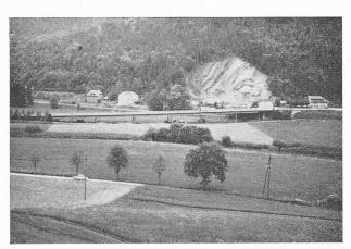
Fig. 5. — Vue générale du viaduc remplaçant le remblai accidenté. La zone claire correspond aux terres qui ont glissé vers l'Areuse lors du poinçonnement des remblais.
