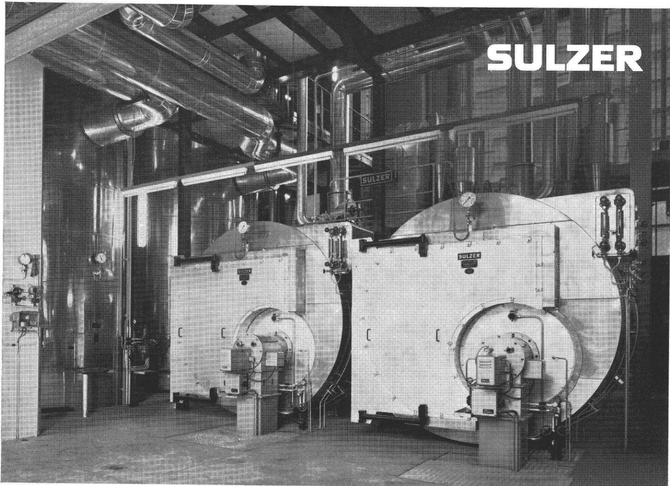
Deux chaudières Sulzer à trois passages avec brûleurs à mazout automatiques dans une usine chimique. Production unitaire 12,8 à 16 t/h de vapeur saturée, pression de service 12 kg/cm<sup>2</sup>.
