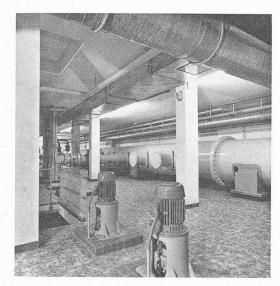
Fig. 3. — Collecteur de refoulement d'eau brute, diam. 1400 mm.
