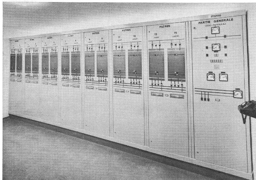
Systèmes électroniques de commande pour les installations de filtration des eaux potables.
