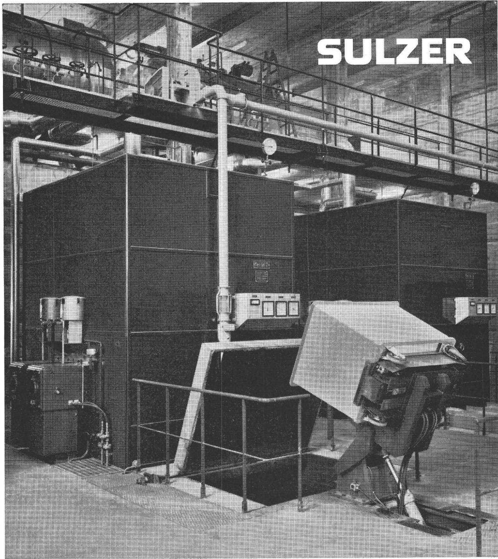
Centrale de chauffe d'un entrepôt équipée de deux chaudières tubulaires à eau surchauffée, de chacune 2,5 mio. kcal/h, avec basculeur hydraulique pour la combustion des déchets les plus divers:
