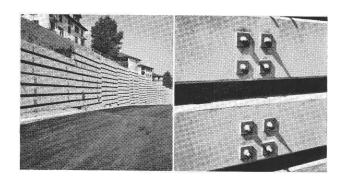
Eléments en béton fixés dans des pieux au moyen de boulons d'ancrage AREFIX.
