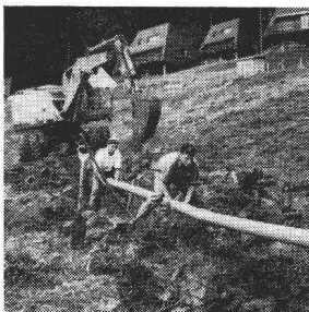
Canalisation Schwyz : Rothenturm
