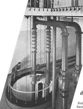
Station de pompage d'eaux souterraines équipée de pompes de forage Sulzer et d'une installation de stérilisation par l'ozone 4.211
