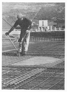
Fig. 8. — Découpage de treillis sur place.
