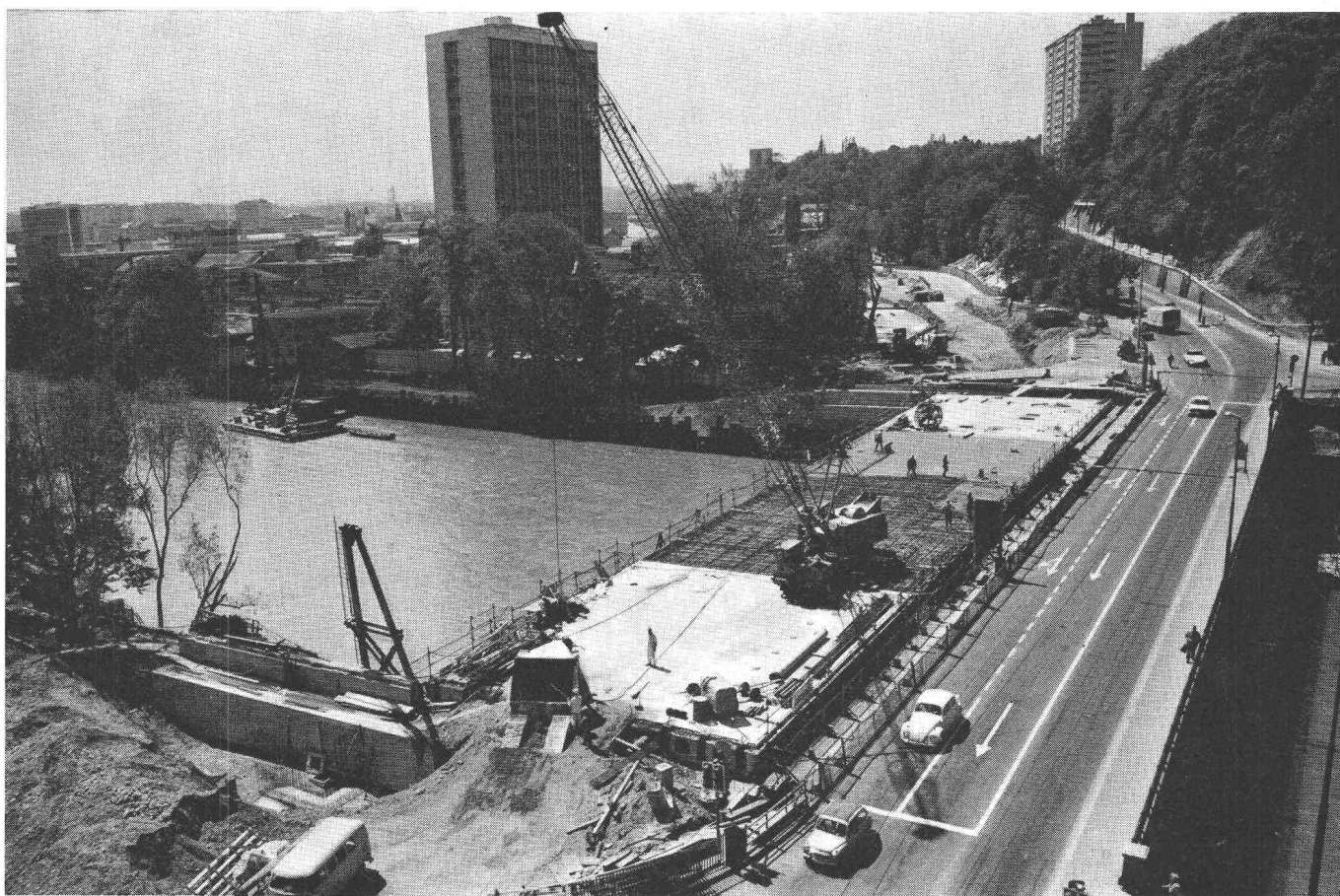
Pont de Saint-Georges sur l'Arve, Genève; Bétonnage du tablier sur éléments préfabriqués Maître de l'ouvrage: Département des travaux publics, Genève Ingénieurs: Bourquin & Stencek, Genève; Société Générale pour l'Industrie, Genève
