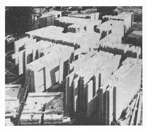
Fig. 4. — Complexe Holeeholzacker. Entreposage provisoire des éléments. Stockage: parois verticalement, plafonds horizontalement.
