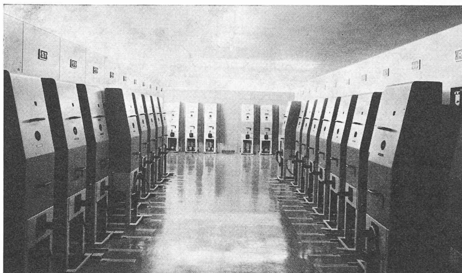
Fig. 2. — Les stoparcs du poste d'alimentation n° 2.
