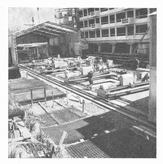
Fig. 2. — Train de machines pour vibration — lissage — superlissage.
