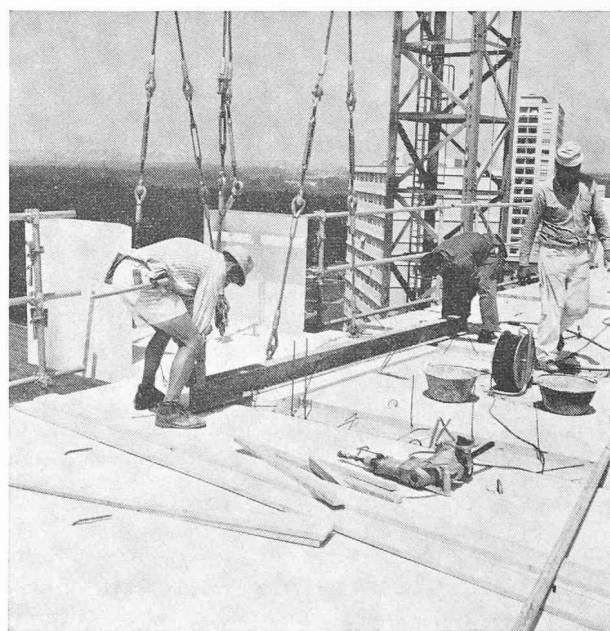
Fig. 8. — Pose d'un balcon.
