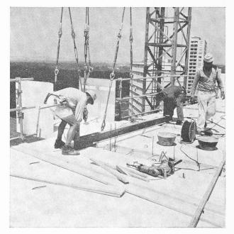
Fig. 8. — Pose d'un balcon.
