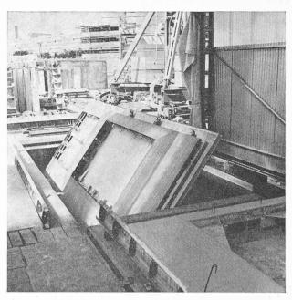
Fig. 4. — Table équipée d'un moule de façade en cours de basculement.
