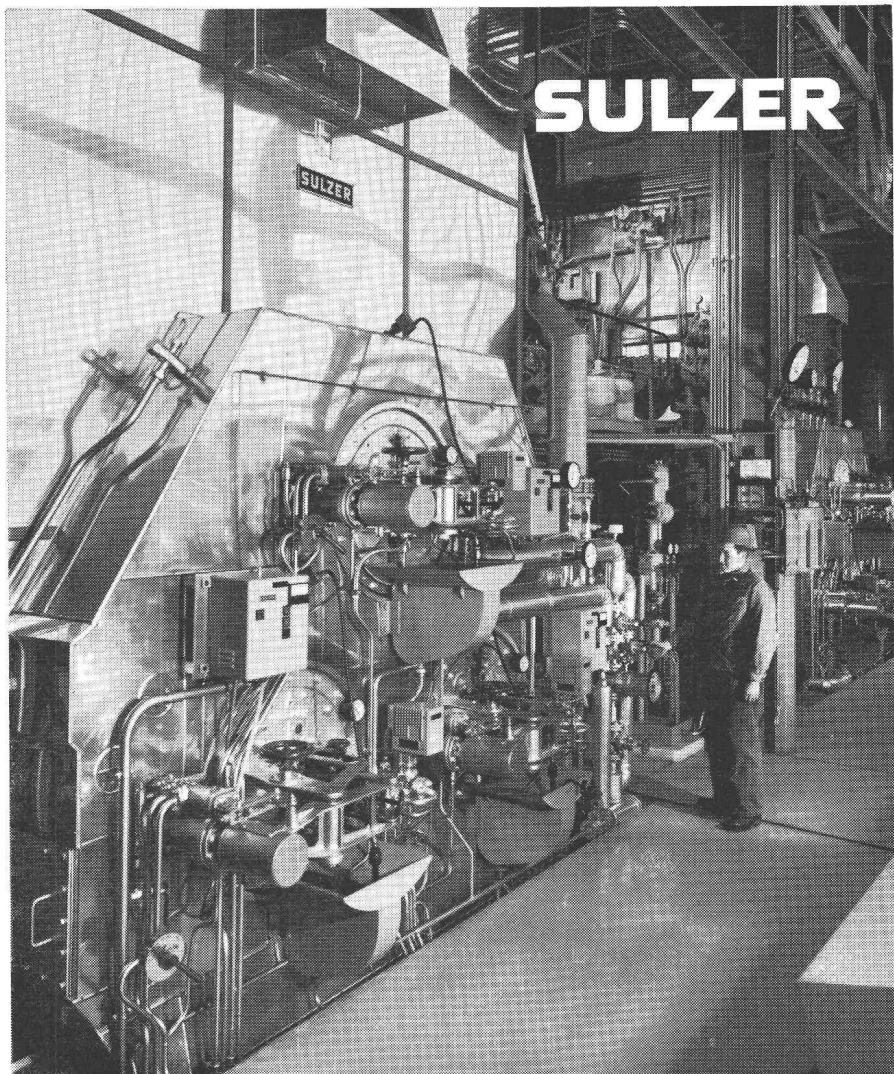
Chaudières à rayonnement Sulzer à haut rendement avec chambre de combustion à surpression et brûleurs à mazout Sulzer. Puissance unitaire 21–26 t/h, 84 kg/cm<sup>2</sup> eff., 520 °C.
