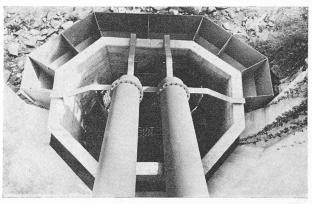
Fig. 2. — Puits amortisseur: vue de dessus.
