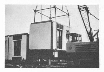
Fig. 10. — Assemblage de cellules complètes.
