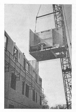
Fig. 9. — Mise en place d'un bloc technique.
