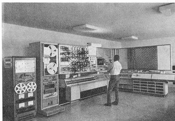
Fig. 3. — Modèle analogique thermique électrique pour l'étude des régimes thermiques variables dans les bâtiments.
