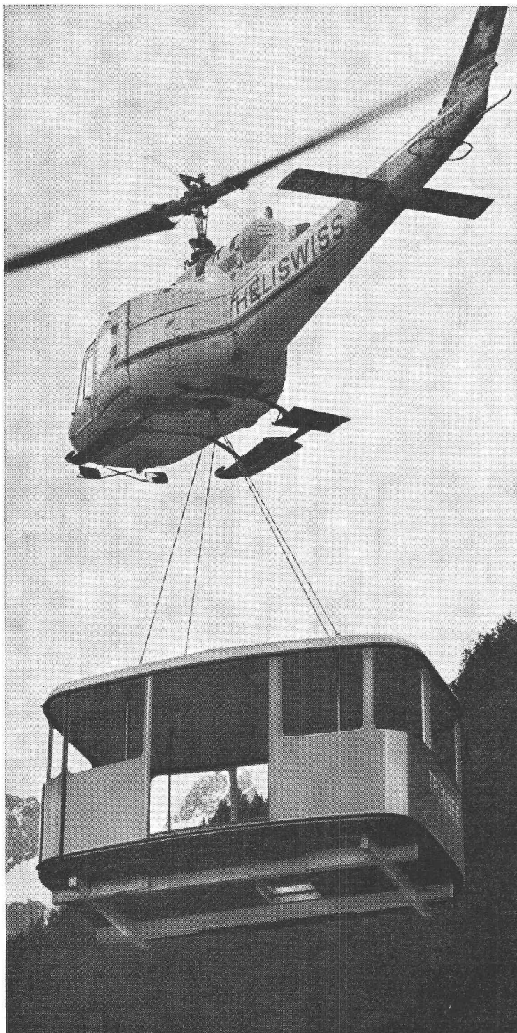
Transport d'une cabine du téléphérique Trübsee-Titlis
