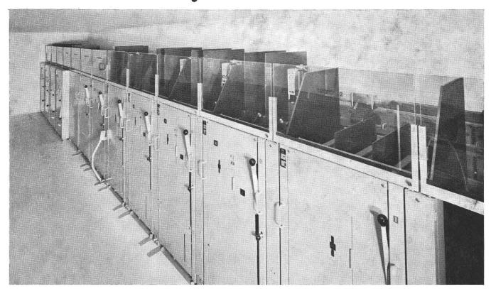
Une technique d'avenir réduit l'encombrement de 55 % par rapport aux cellules de construction conventionnelle. Des locaux de 2 mètres de hauteur suffisent pour loger des cellules 12 et 24 kV d'une largeur unifiée de 750 mm.
