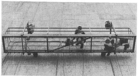
Sécurité multiple. Hauteur de travail illimitée. Commande par un seul homme. Réglage automatique de la position horizontale. Charge utile 550 kg.
