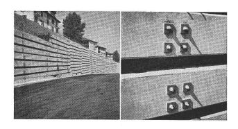
Eléments en béton fixés dans des pieux au moyen de boulons d'ancrage AREFIX.
