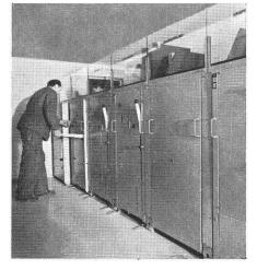
tions de réseaux. Cette installation résiste à des puissances de court-circuit pouvant atteindre 1000 MVA sous 24 kV.
