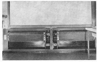
Fig. 6. — Convecteur de climatisation placé sous une fenêtre.
