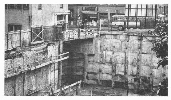
Fig. 3. — Reprise en sous-œuvre de l'immeuble Selnaustrasse 6.
