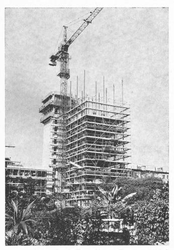
Fig. 7. — Construction de l'immeuble-tour. Les poteaux métalliques sont posés par éléments de  $14\ \mathrm{m}$ .
