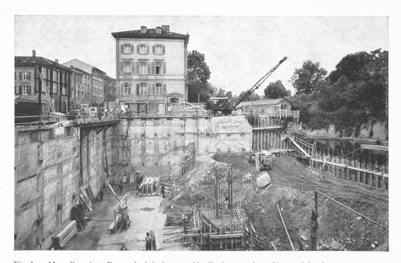
Fig. 4. — Murs d'enceinte. De gauche à droite : paroi berlinoise, paroi moulée et palplanches.
