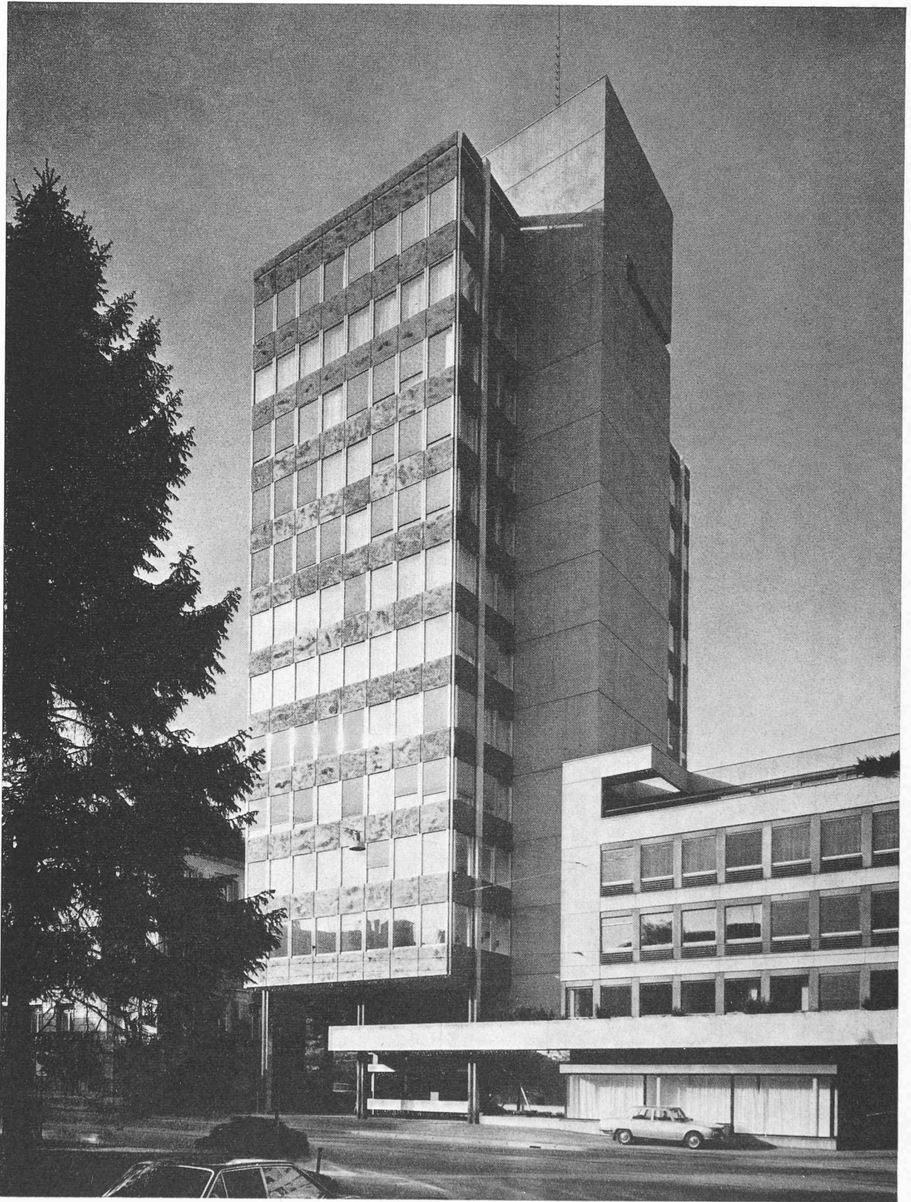
Façade sur la rue, avec, à droite, l'immeuble Selnaustrasse 12, construit en même temps que la maison SIA par le même architecte.
