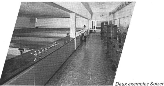
▲ Installation de filtres rapides de Champ-Bougin, appartenant à la ville de Neuchâtel, pour le traitement d'eau du lac en eau potable. Capacité 1800 m³/h
