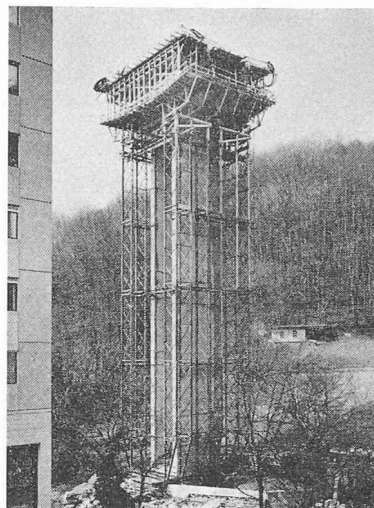
Fig. 7. — Palée 3 prête à recevoir les chariots.
