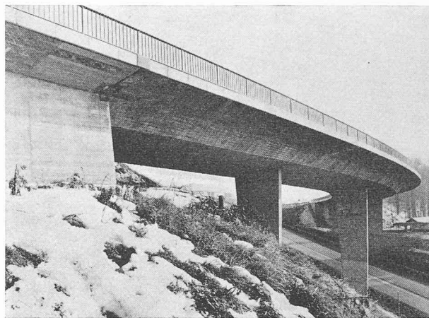
Fig. 3. — Vue depuis l'extrémité côté Châtel-Saint-Denis.
