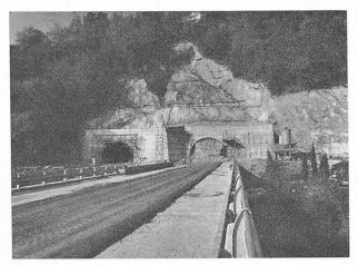
Fig. 7. — L'éboulement consolidé et le mur de pied.
