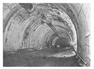
Fig. 10. — L'étayage métallique en cours de dépose.
