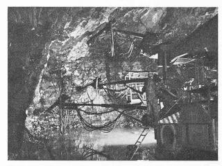
Fig. 11. — Attaque nord au jumbo.
