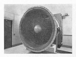
Fig. 15. — Un ventilateur (portail sud du tunnel aval).
