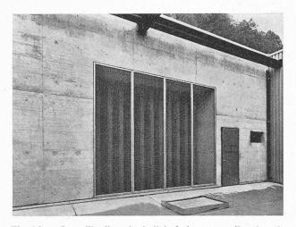
Fig. 16. — La grille d'entrée de l'air frais au portail sud aval ; remarquer, derrière le grillage, les filtres d'insonorisation.
