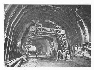
Fig. 12. — Coffrage du béton de revêtement.
