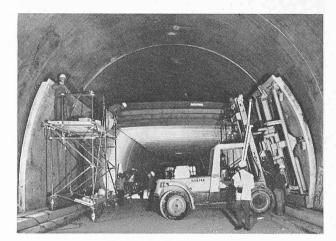
Fig. 13. — Pose d'un élément préfabriqué de piédroit.
