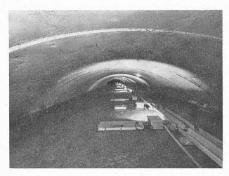
Fig. 14. — La gaine de ventilation avec les boîtiers de luminaires; de part et d'autre, on voit les gaines réglables de distribution de l'air frais.
