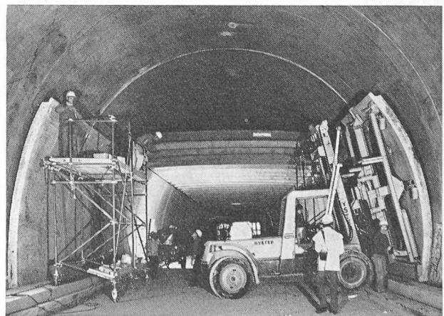
Fig. 13. — Pose d'un élément préfabriqué de piédroit.
