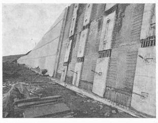
Fig. 5. — Mur ancré, vue avant la pose du béton de parement.
