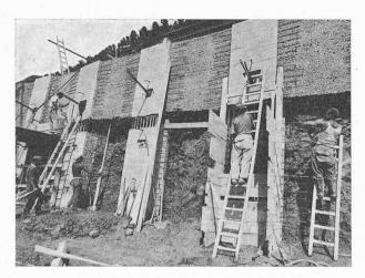
Fig. 4. — Mur ancré, exécution de la deuxième étape.
