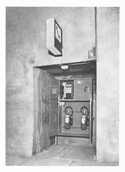
Fig. 9. — Niche de secours avec téléphone, dispositif d'appel et extincteur.
