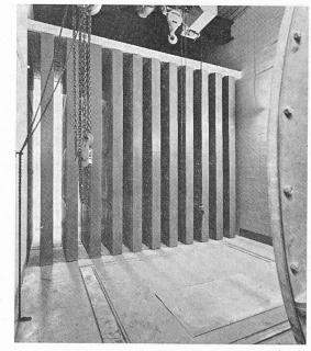
Fig. 6. — Station de ventilation du portail sud, avec bloc d'insonorisation.
