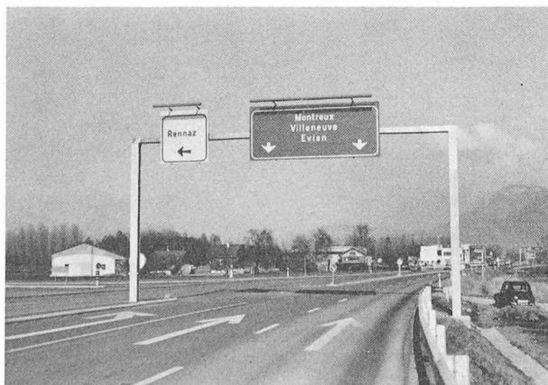
Fig. 3. — Portique de signalisation à Rennaz.
