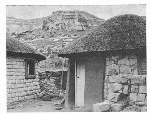
Fig. 3. — Grès taillé, crépis de Dila, grès brut, joints en terre argileuse.
